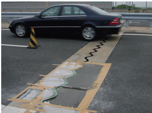
空港誘導灯基台の急速固定（路盤との隙間充填）
