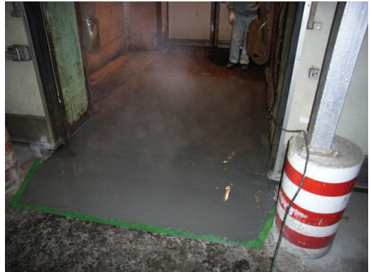
冷凍倉庫出入口の床面補修
